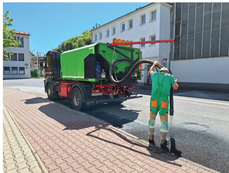
Oprava komunikácií v areáli starého závodu.
