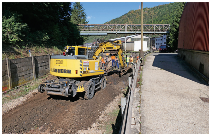
Počas generálnej opravy železničnej vlečky.
