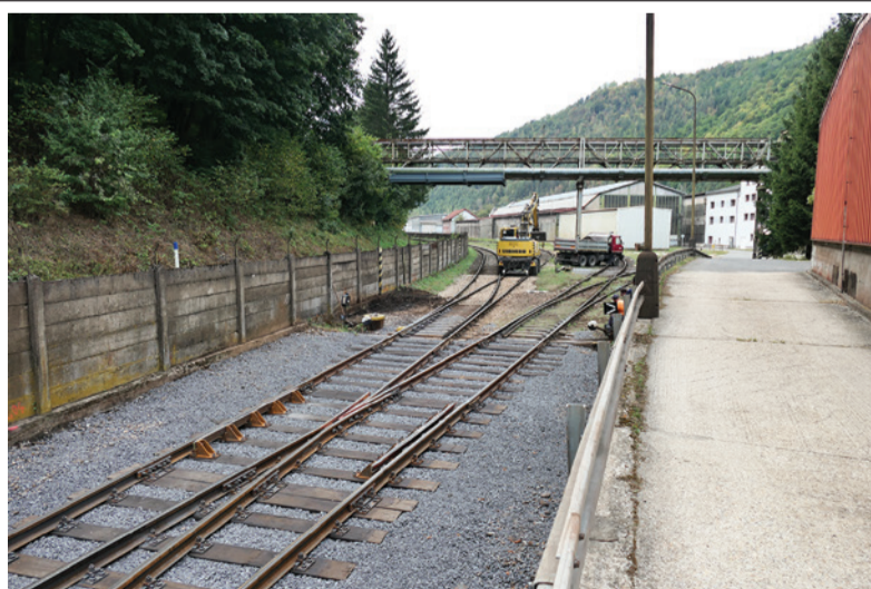
Nové koľajnice tesne po ukončení generálnej opravy.
