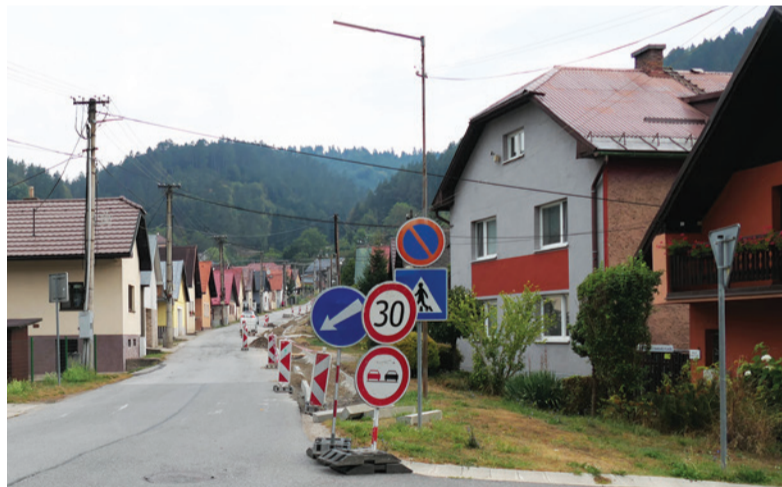
Tatranská ulica vo Valaskej, na ktorej v súčasnosti prebiehajú stavebné práce. Foto: T. Kubej
