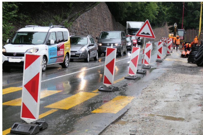
Rekonštrukcia cesty I/66 potrvá do novembra.
