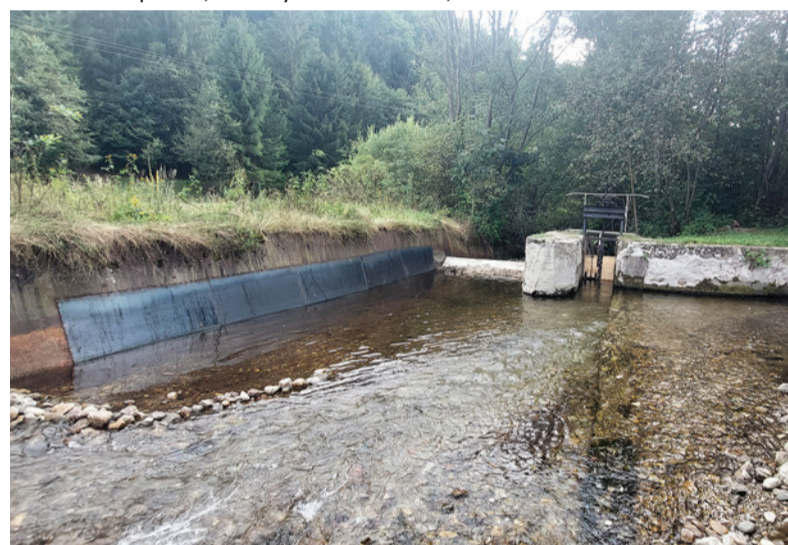
Opravené betónové časti a vymenené jalové stavidlo na hati Štiavnička. Foto: M. Jančovič
