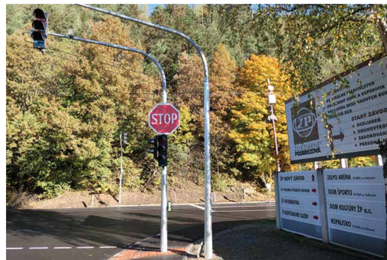
Svetelná signalizácia s dynamickým riadením premávky na križovatke v Podbrezovej.
