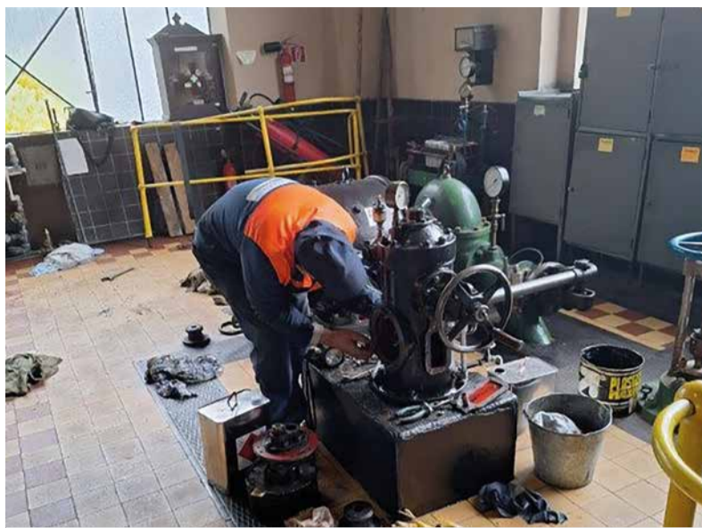
Oprava rotačného budiča v hydrocentrále Jasenie.
