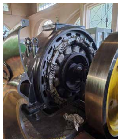
Vyčistenie vinutia generátora v hydrocentrále Jasenie. Foto: J. Kováčik
