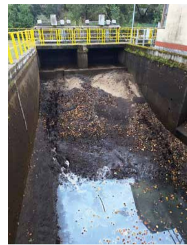
Na hati v malej vodnej elektrárni Predajná bolo potrebné vyčistiť bazén od nánosov piesku a bahna. Foto: J. Kováčik
